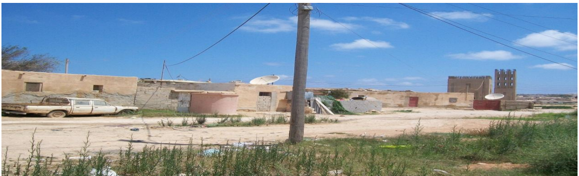
توصيل الكهرباء بطريقة عشوائية بحي الحطية تصوير الباحث 2010
