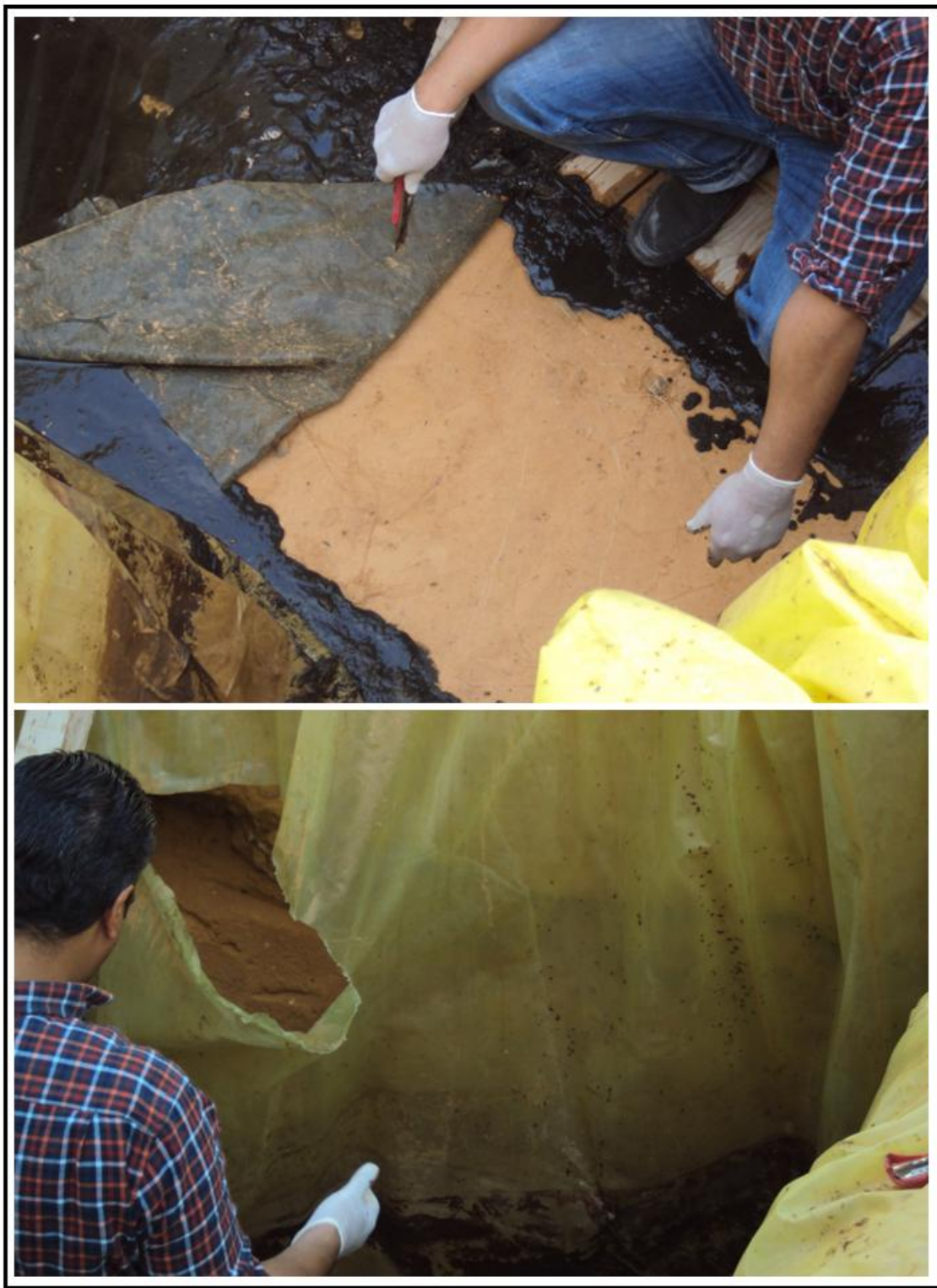
الشكل 6-1: صور الكشف عن حالي التربة والبطانة الجيوبلاستيكية بعد تفريغ الماء الأسود.
