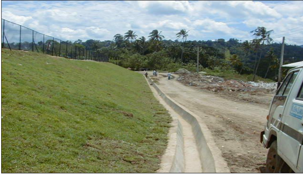
الشكل 2-8: النموذج المثالي لقنوات تصريف مياه الرش [12].
