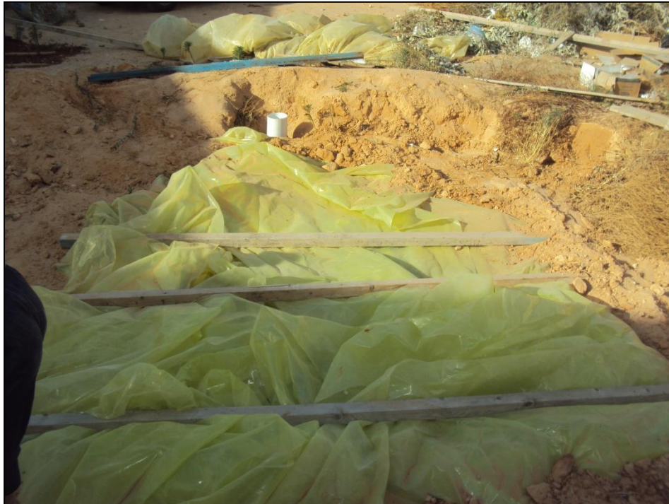
المشهد 5-3: بناء سقف نموذج البئر الأسود وتجهيز بئر المراقبة.
