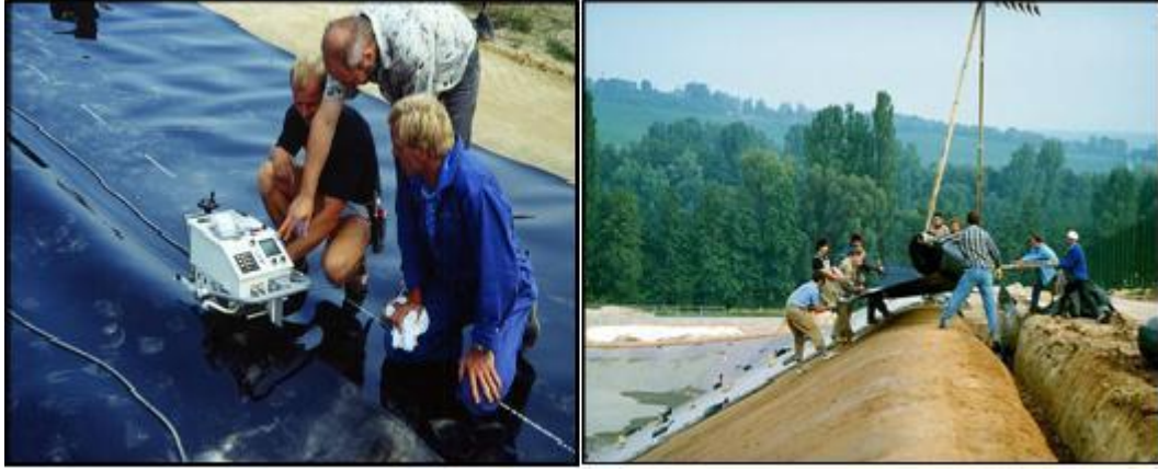
الشكل 2-9: تركيب بطانة الغشاء جيوبلاستيك بسمك 1.8-2.5 مم من بولى أثيلين عالى الكثافة [12].
