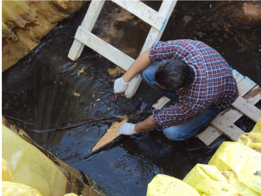
المشهد 5-13: الكشف عن حالي التربة والبطانة الجيوبلاستيكية بعد تفريغ الماء الأسود.
