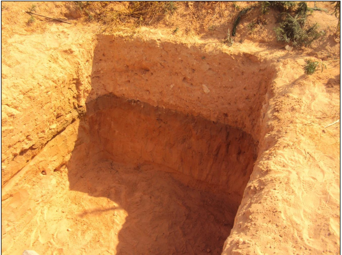
المشهد 5-1: صورة حفرة نموذج البئر الأسود التجريبي قبل التغليف بالبطانة الجيوبلاستيكية.
