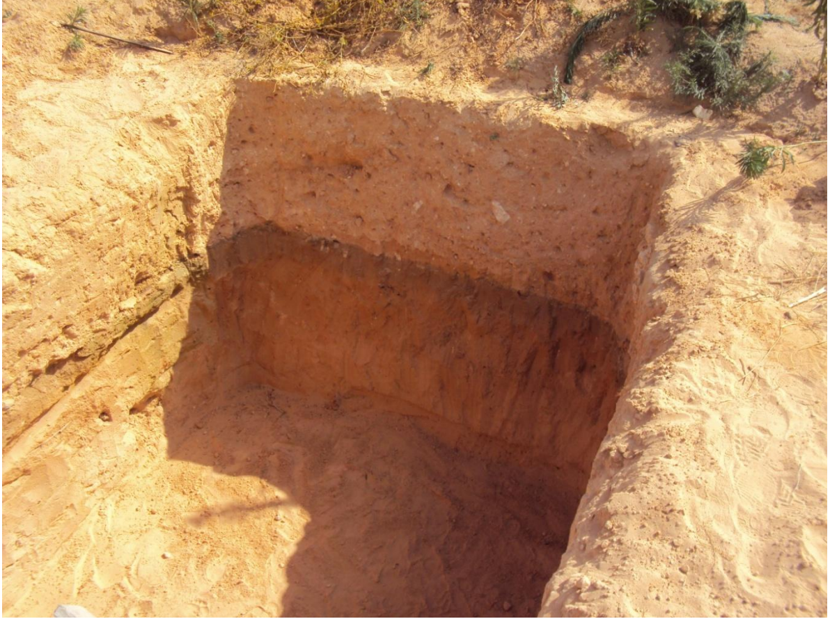
الشكل 3-19: صورة حفرة نموذج البئر الأسود التجريبي قبل التغليف بالبطانة الجيوبلاستيكية.
